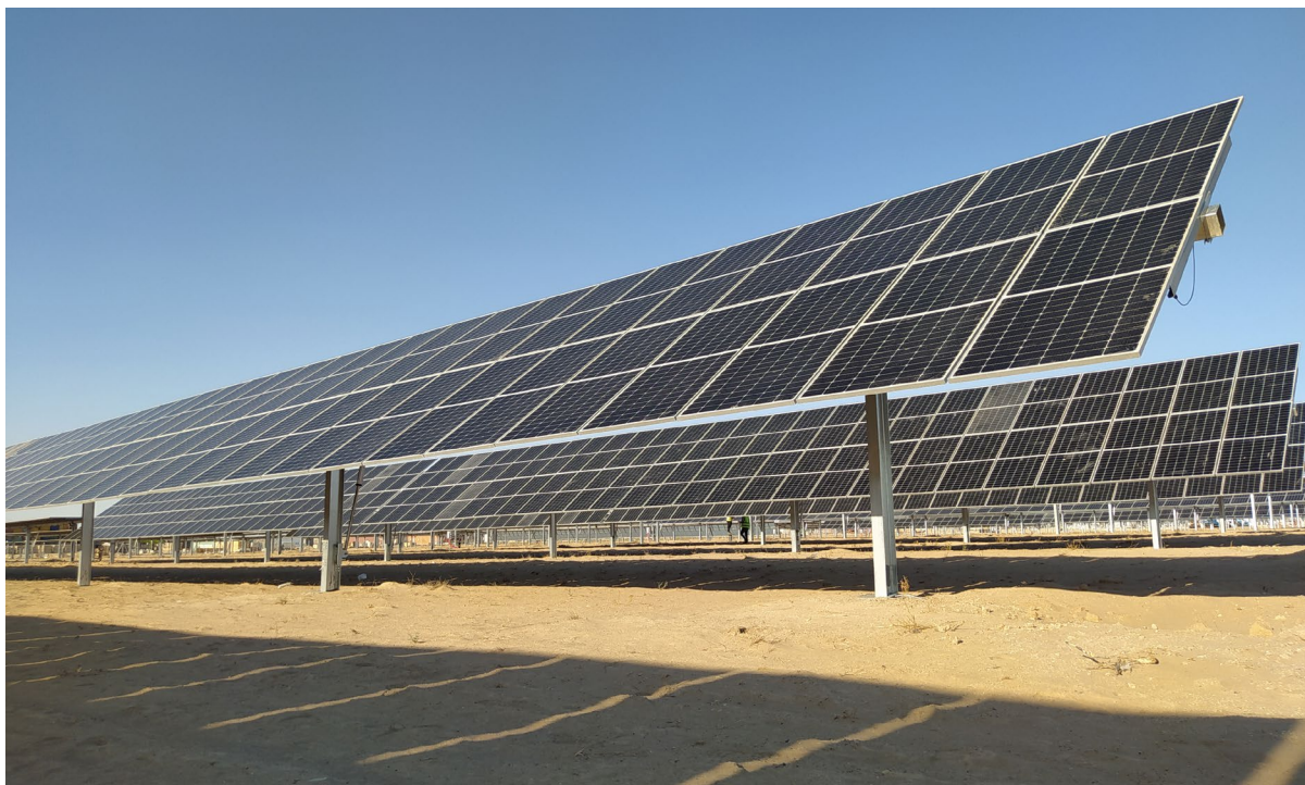
Рисунок 14. Установка солнечных панелей
